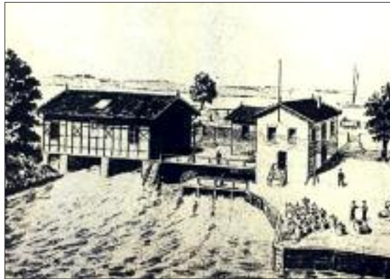
Abbildung 3: Hier am Mühlenwehr in Zehdenick wurde Wasserkraft in elektrischen Strom für die Ziegelkähne gewandelt. (Quelle: Stadtarchiv Zehdenick)
