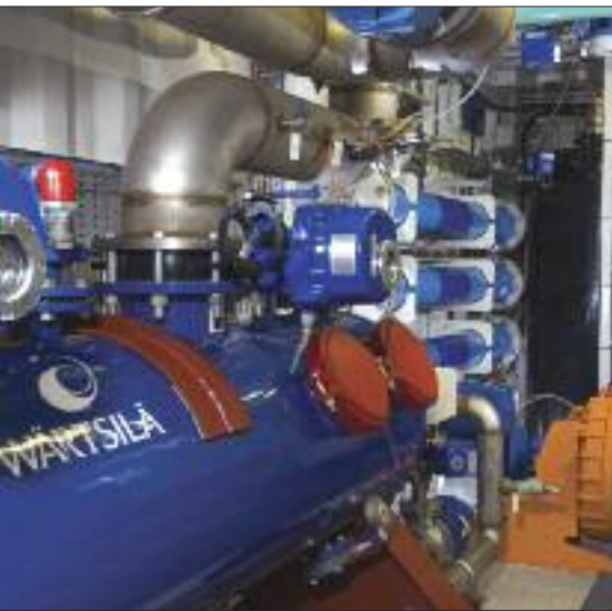
Das zweite von Wärtsilä angebotene Ballastwasser-Behandlungssystem „Aquarius EC“ ist für Strömungsgeschwindigkeiten zwischen 259 und 4000 m 3 /h geeignet und arbeitet ebenfalls mit einem Filter, dem jedoch ein Elektrolyseverfahren nachgeschaltet ist. Die Filterstandzeit ist dieselbe wie beim UV-System. Der bei der Elektrolyse frei werdende Wasserstoff wird dem Wasser entzogen, bevor es in die Ballasttanks gelangt.
