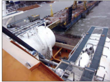
Abbildung 4: LNG Tanks der „Viking Grace“ auf Deck 6. (Quelle Markus Rantala Wikipedia)
