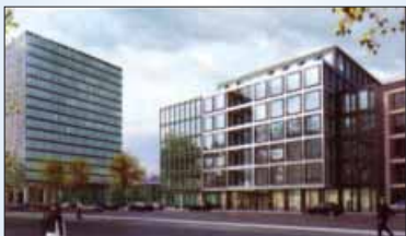
Gesamtansicht der neuen Hamburg Süd-Zentrale.
