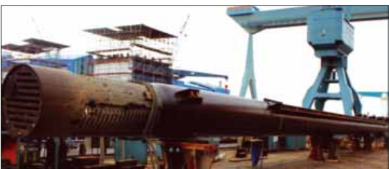
Abbildung 20: Rohr mit Zahnstange zur Seewasserversorgung. (Foto: Dr. Hochhaus)
