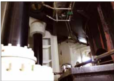
Abbildung 13: Jacking-System, die Hubzylinder greifen oben an dem Führungsrahmen an. (Foto: Dr. Hochhaus)
