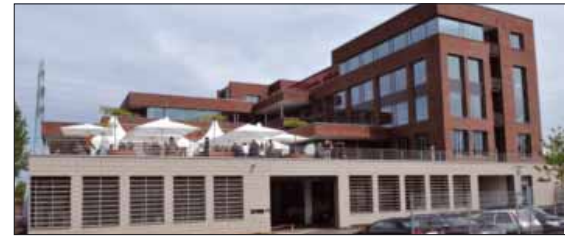
Bietet räumliche Reserven für die geplante Expansion: Attraktiver Neubau im Harburger Binnenhafen: der neue Firmensitz von Becker Marine Systems. Fotos Jens P. Meyer
