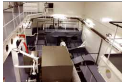
Abbildung 18: Backbord-Antriebsanlage mit zwei Elektromotoren, Getriebe, Welle und Verstellpropeller. (Foto: Dr. Hochhaus)
