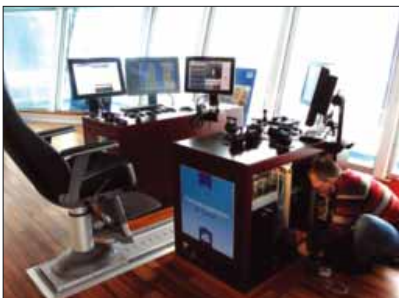
Abbildung 10: Brücke, Fahrstand zur dynamischen Positionierung. (Foto: Dr. Hochhaus)
