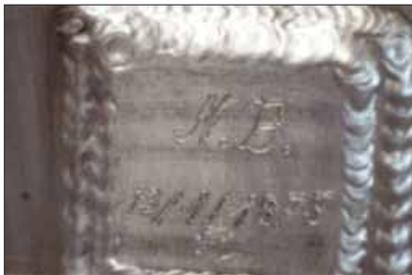
Verschweißte Verschlussplatte mit Neubau- nummer und GL-Siegel.
